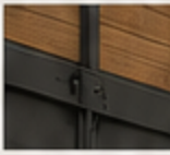
PISO E FIXAÇÃO
